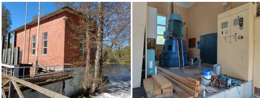
Virtaankosken entinen voimalaitos ulkoa ja sisältä. Voimala lopetti toimintansa vuonna 2012.
