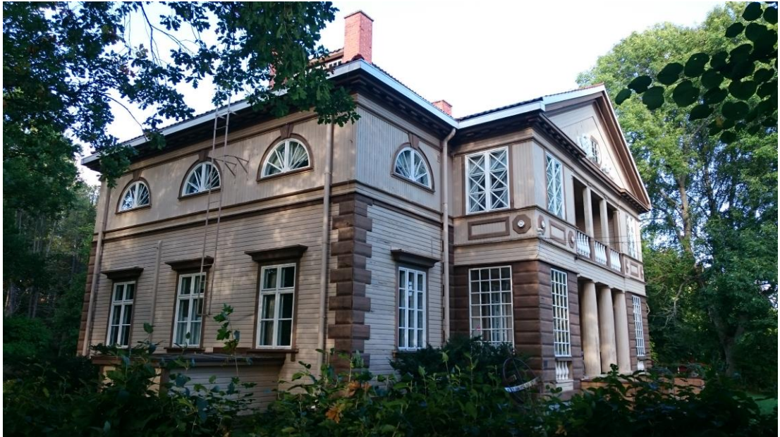
Kuva 10. Rapalan kartanon päärakennus Rapalanlammen puolelta kuvattuna.
