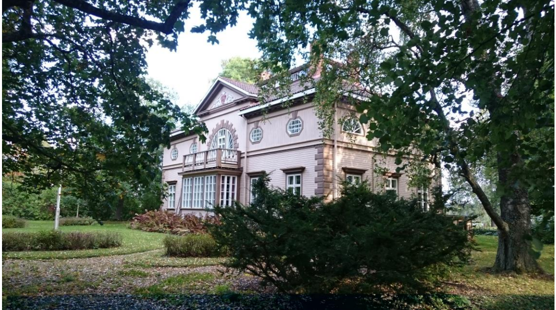
Kuva 9. Rapalan kartanon päärakennus sisäpihan puolelta kuvattuna.
