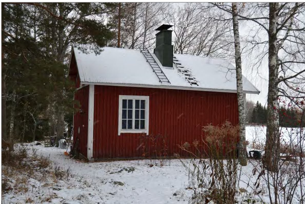
Kuva 47. Rakennus nro 13, länsisivu.
