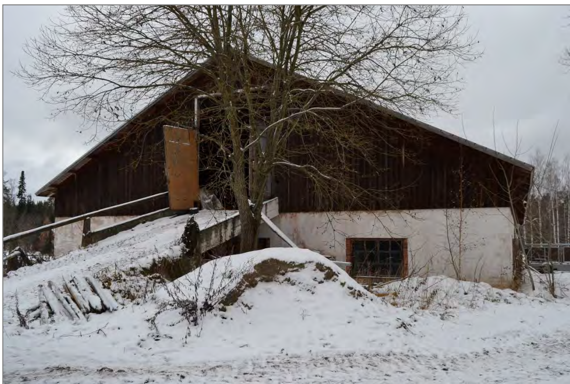
Kuva 40. Betoninen ajoramppi navetan eteläpäädyssä.
