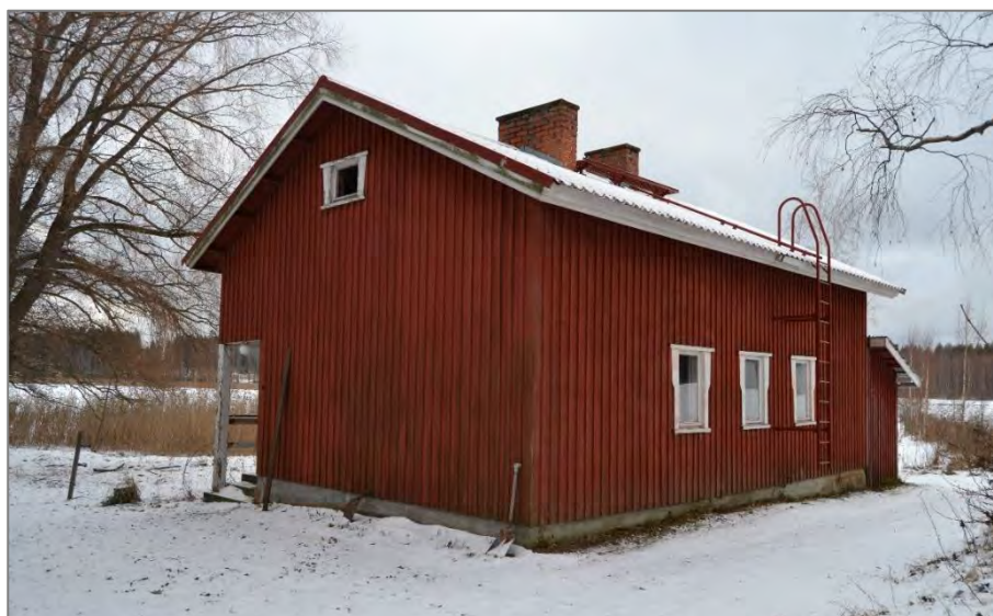
Kuva 43. Saunan itäpääty ja pohjoissivu.
