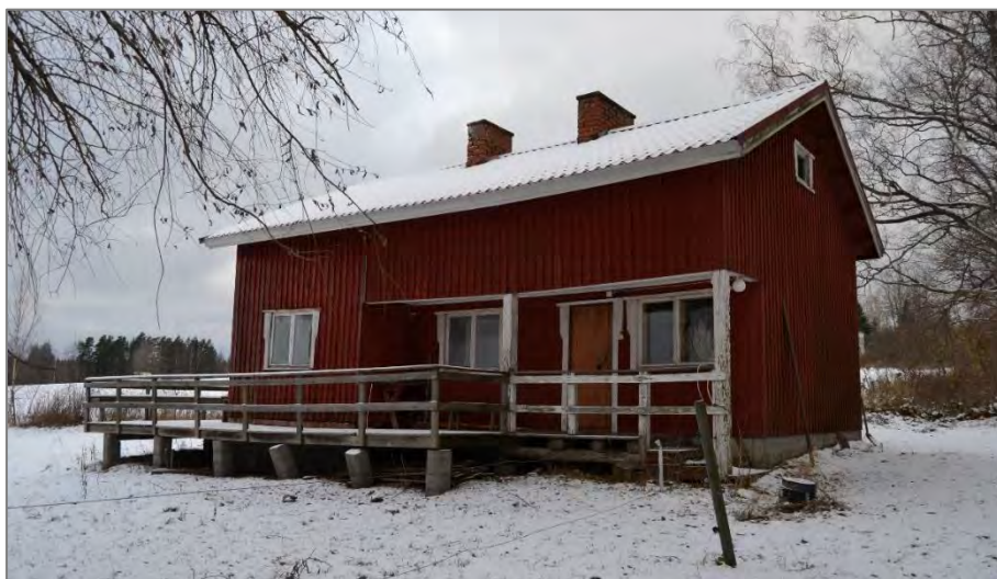
Kuva 42. Saunarakennus kuvattuna rannan puolelta.
