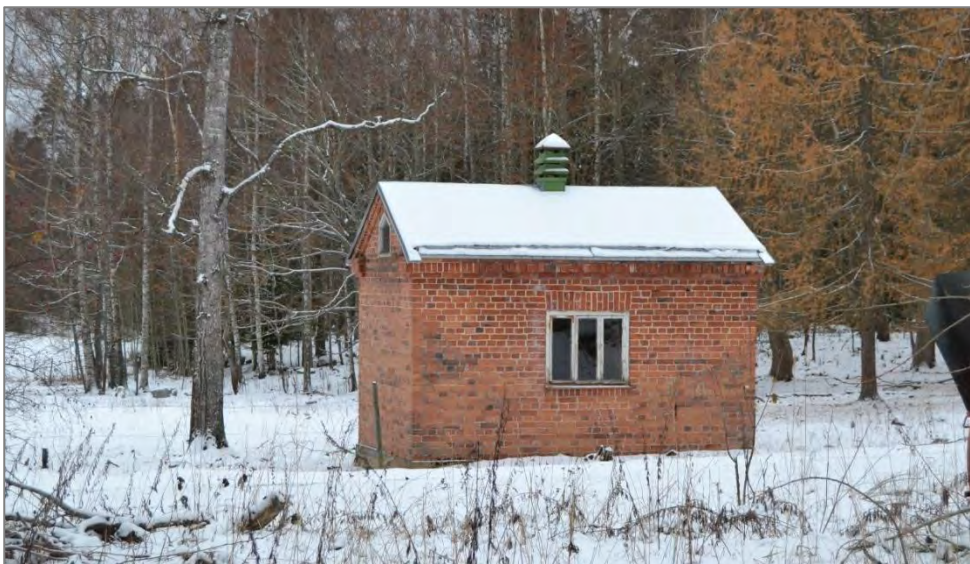
Kuva 37. Rakennuksen eteläsivu ja länsipääty.
