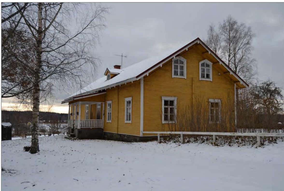
Kuva 27. Rakennuksen pohjoispääty ja itäsivua.
