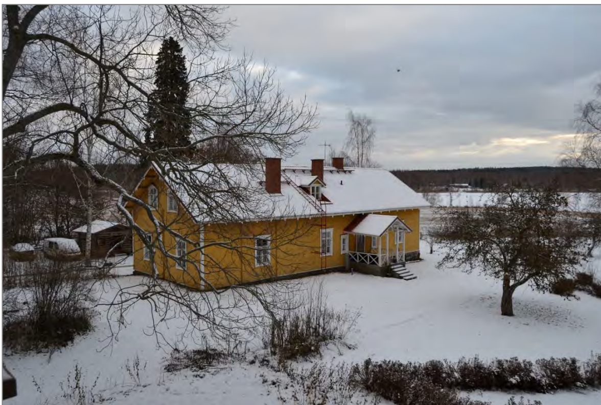
Kuva 26. Väentupa kuvattuna päärakennuksen parvekkeelta marraskuussa 2023.
