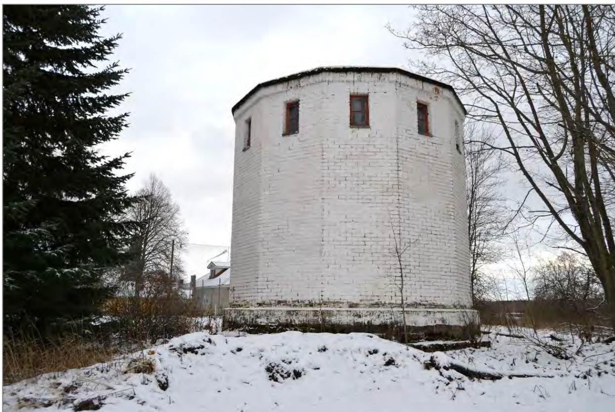
Kuva 41. Rapalan vesitorni kuvattuna lännen puolelta.
