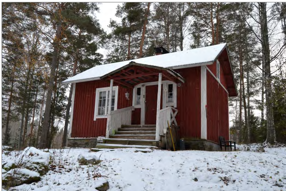
Kuva 48. Rakennus nro 14, itäisivu ja pohjoispääty.
